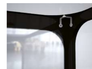
Unión cristales Glass panels join
